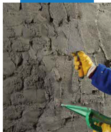
Нанесение шпателем
