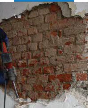
Подготовка основания – удаление существующей штукатурки
