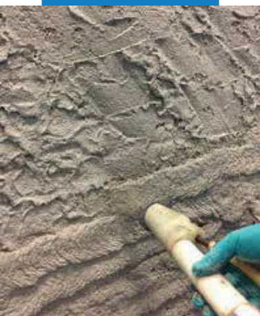
Нанесение Poromap Deumidificante (Поромап Санирующий) с помощью штукатурной станции
